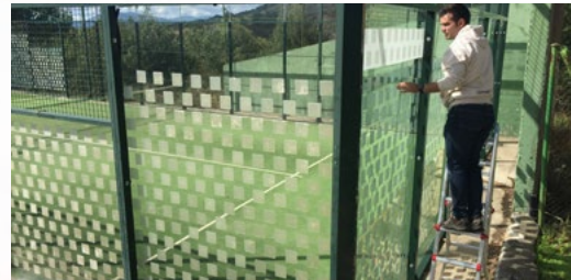
Durante la colocación de medidas anticollisión
