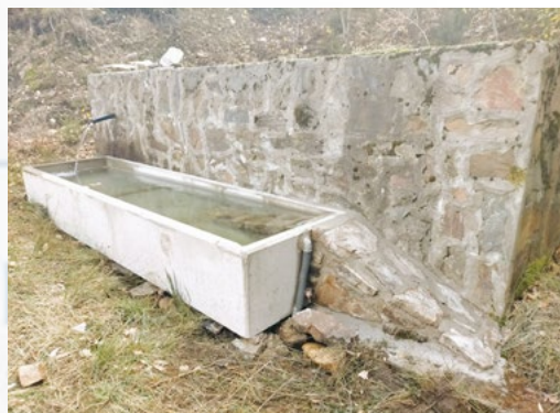
Abrevadero con rampa de acceso y escape
