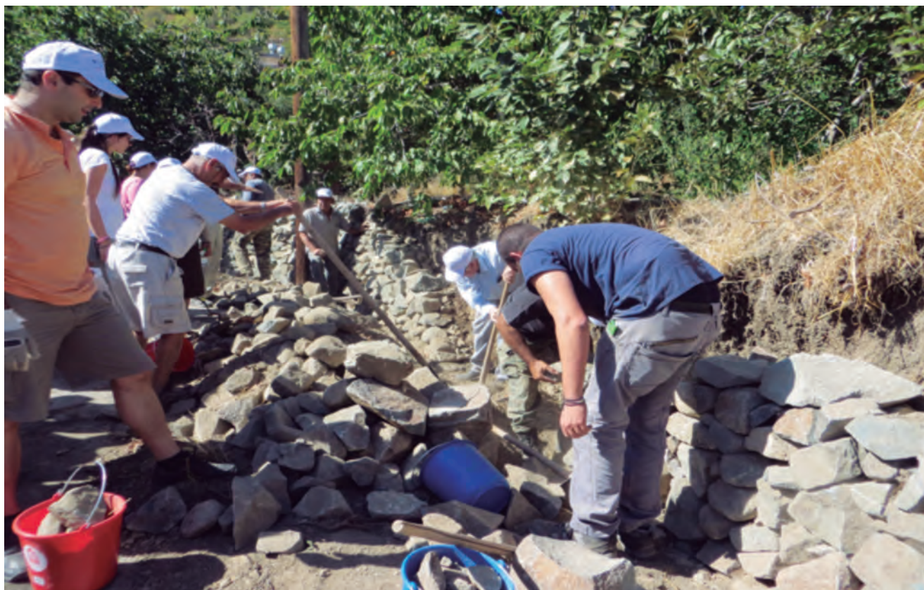
Curso de formación de técnicas de construcción tradicionales, piedra en seco.
